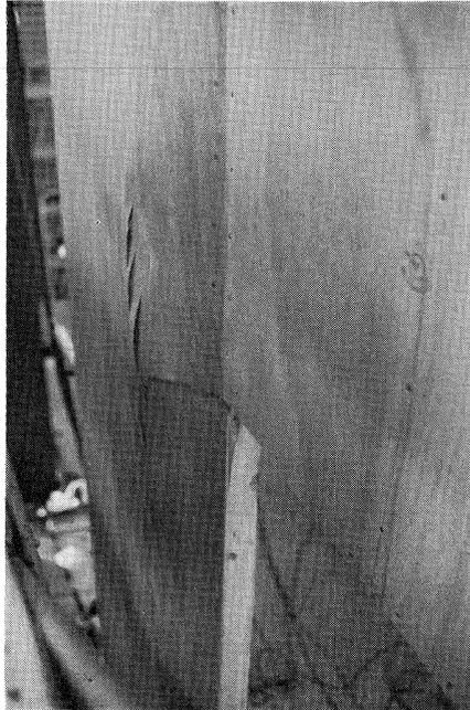
**Photo. 13** 開口壁において二次的に発生した圧縮力による合板の座屈破損（掃き出し開口部）
