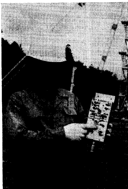
写真26. エンドレスタイラー式索張り用スイッチボックスを持って「下降」の押しボタンスイッチを押している。
