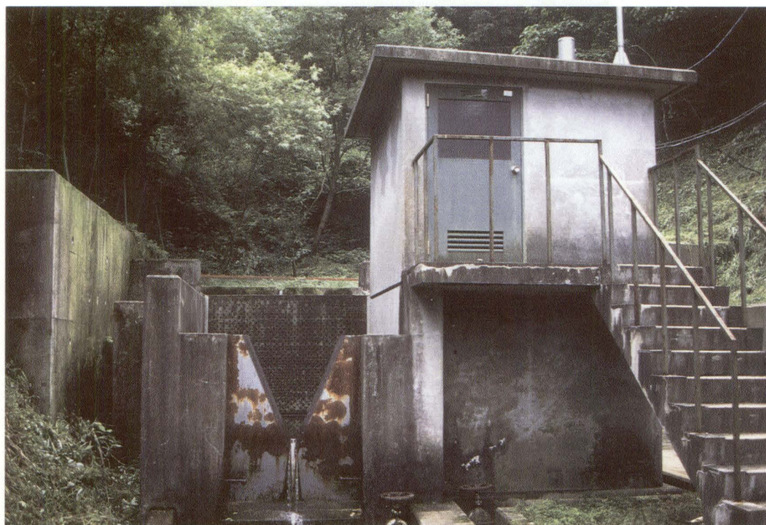
写真1 筑波森林水文試験流域の量水堰
