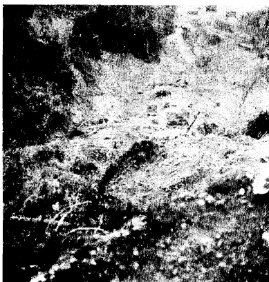
写真 9 赤色土の崩壊（大坪川平山） Phot. 9. Landslide in red soil.
