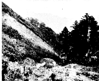
写真 10 溪岸崩壊（清滝川） Phot. 10 Landslide along stream.
