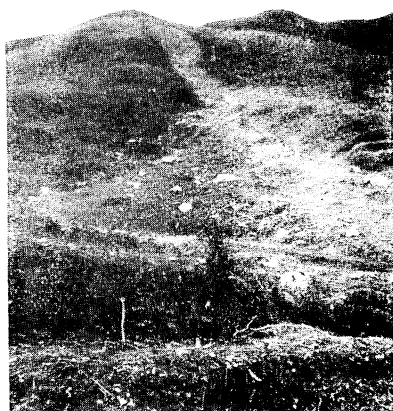
写真 1 山腹崩壊 (戸上山大川) Phot. 1 Landslide on hillside.
