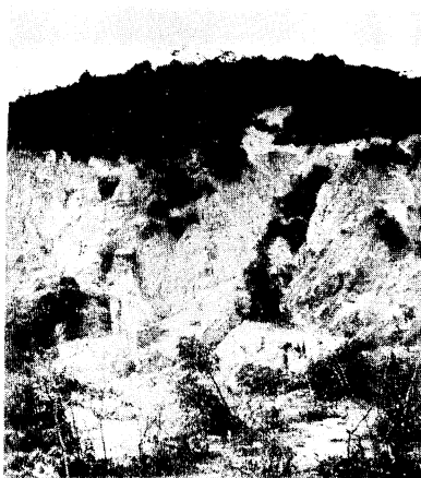
写真 8 赤色土の崩壊（丸山谷） Phot. 8 Landslide in red soil.
