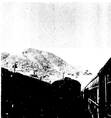
写真 12 風師山表門司の崩壊 Phot. 12 Landslides on Kazashiyama.
