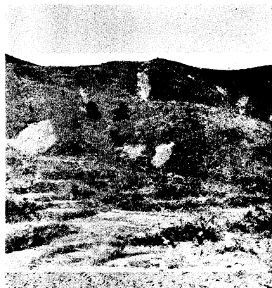
写真 15 風師山系大坪川流域の崩壊 Phot. 15 Landslides on Kazashiyama.
