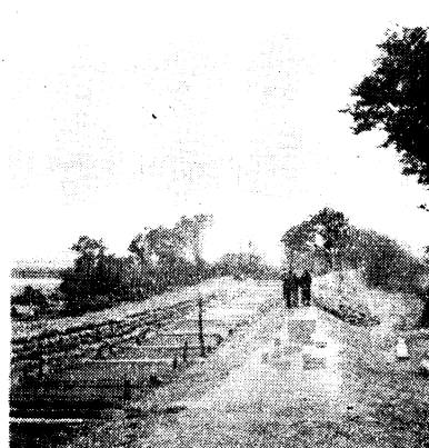
Phot. 71 堤防の欠潰（玉水） Collapse of embankment
