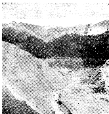
Phot. 17 天然ダムの欠潰 (金剛寺) Collapse of natural dam
