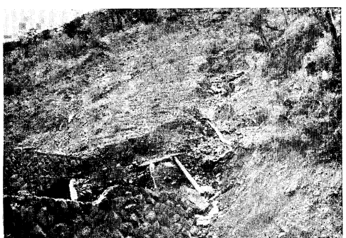
写真 11 槇山川支流口西谷第 1 号堰堤 (横断面 No. III 1 )
