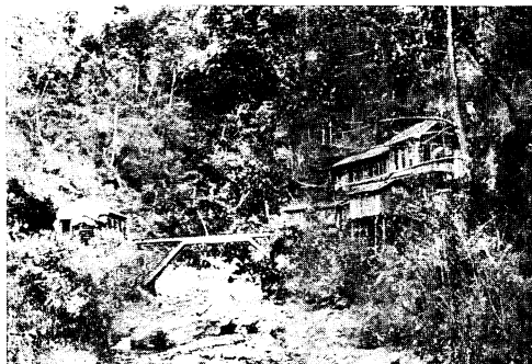
写真 2 槇山川 No. III 横断面付近 (同上・別府斫伐事業所)
