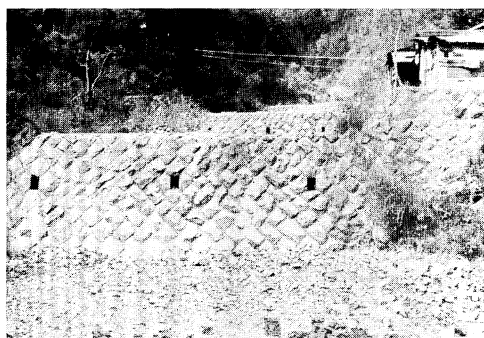
写真 34 佐喜浜川水源治山事業所付近 砂防堰堤
