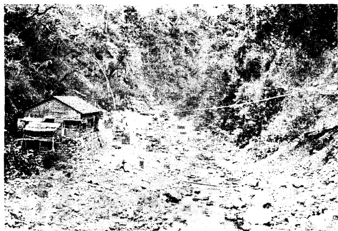
写真 1 槇山川 No. II 横断面付近 (高知営林局物部川第二治山事業所・別府)
