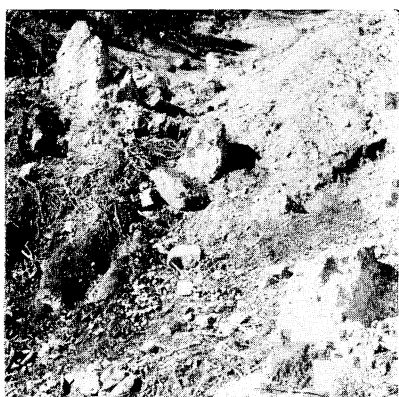
10. 十谷崩壊露岩部
