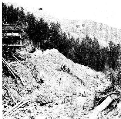
13. 平清水天然ダム欠壊跡
