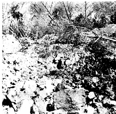
Phot. 22 大崩壊の一部（ビヤ沢）
