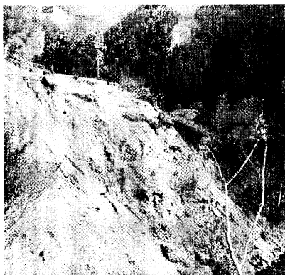
Phot. 21 溪岸崩壊（久野）
