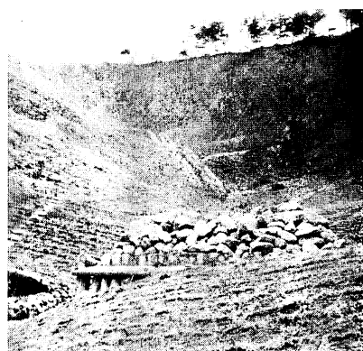
Phot. 24 崩壊施工地（宇津ノ谷峠）
