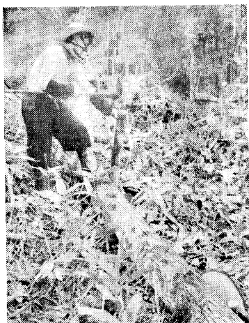
写真 90 土止め材および杭打ち
