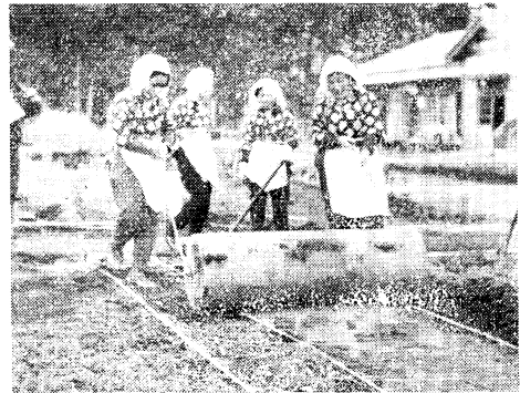
写真10 ローラによる床固め
