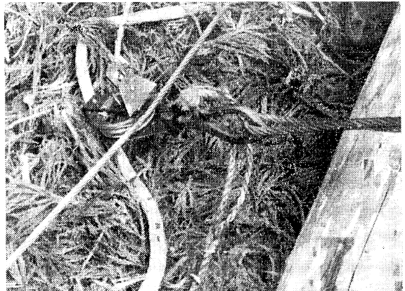
写真 1 荷縛索に取付けた横取滑車に引戻索をかけたところ
