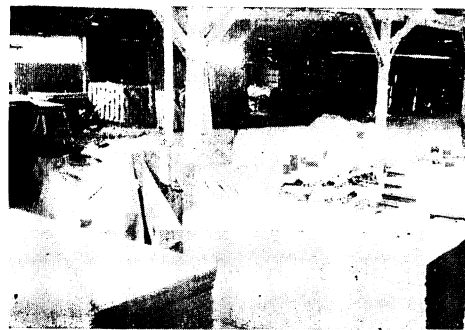
第16図 キャンバスをかけてスチーム加熱
