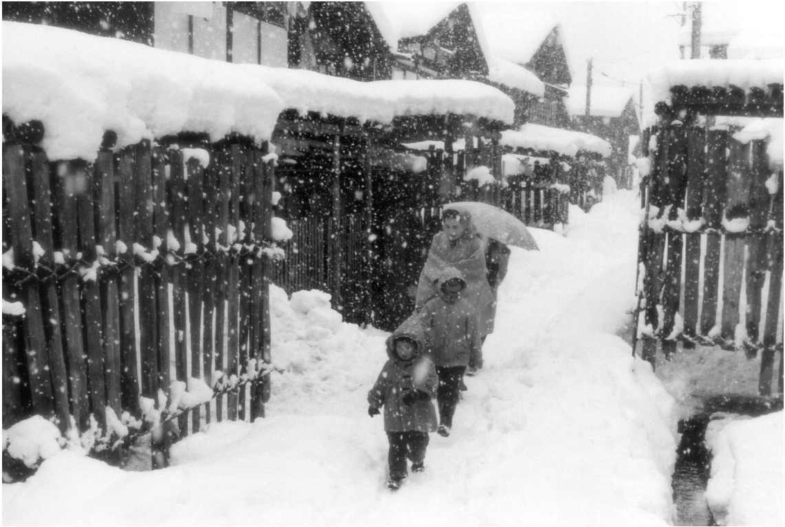
雪柵（玄関が雪でふさがれるを防ぐために木で組んだ囲い）のある通り 1958/2
