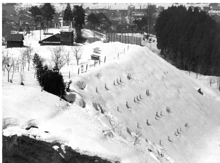
写真 1 雪崩対策の試験のため、実験斜面に多数の杭（鉄道のレール）を設置しました。国鉄（現在の JR）との共同研究（昭和 38 年 3 月 19 日撮影）。
