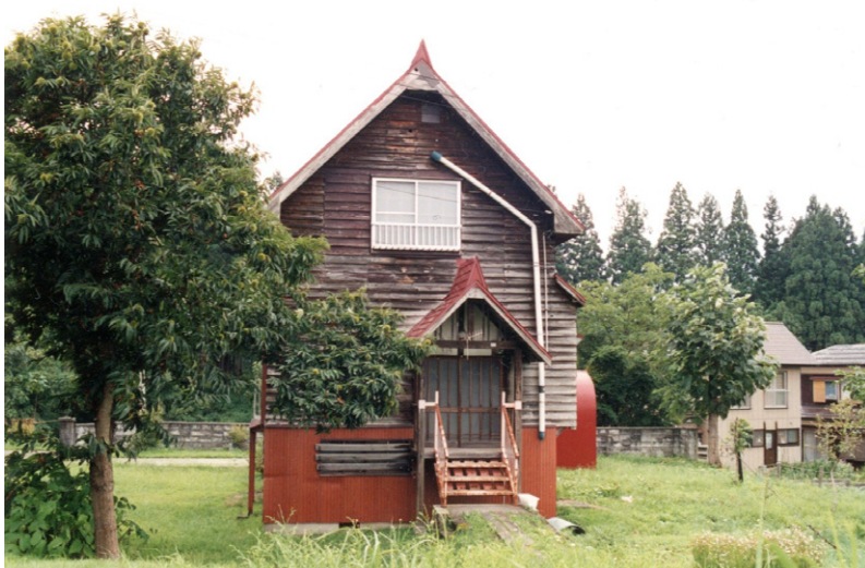
写真 8 高橋喜平氏が設計した雪の家（十日町試験地の官舎）。高床式で自然落雪のため雪下ろしの手間が省け，2 階，3 階の室内は雪に埋もれずに明るく暮らせます。屋根の最上部の雪割りは高橋氏の考案によるものです（平成 12 年頃撮影）。
