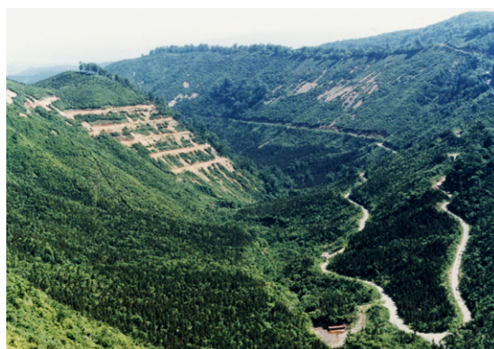
写真6 階段工が施工され，雪食が止まりました（昭和62年6月17日撮影）。
