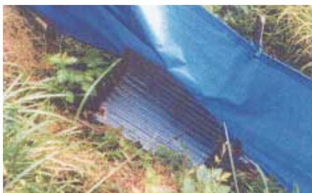
写真3-23 シート下をくぐり抜けた跡
