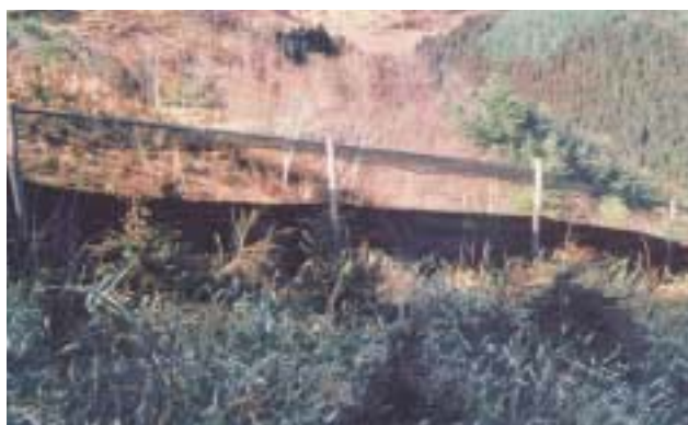
写真1-7 遮光シートを用いた防護柵
