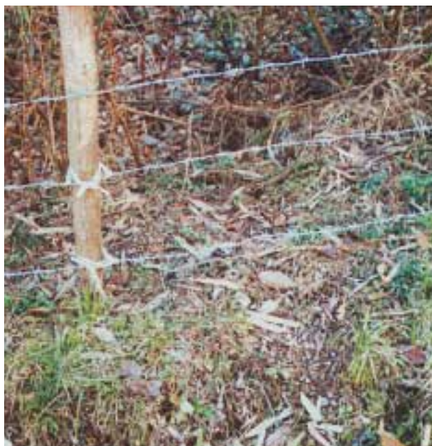
写真3-25 有刺鉄線柵 一見分からないが、侵入可能である
