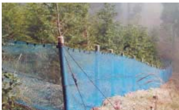
写真1-8 防風ネットを用い防護柵 (支柱は間伐材を使用している)
