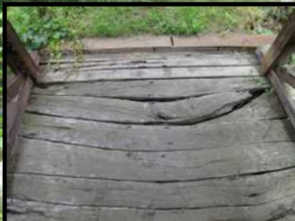
愛媛県喜多郡内子町「田丸橋」
