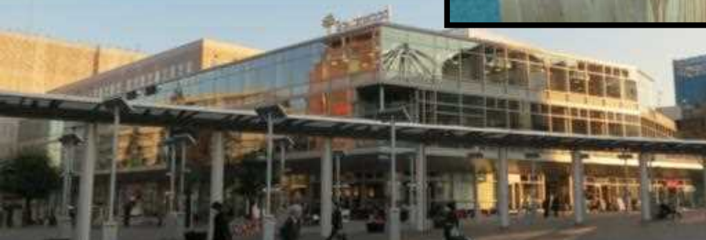
神奈川県横浜市「サウスウッド」
