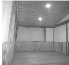
スギ板貼り内装
