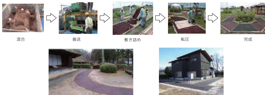
図5. 試験施工
