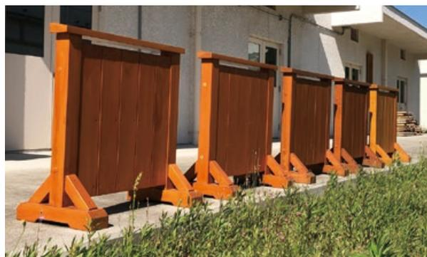
図4 CNF配合塗料を下塗りに用いて塗装した木製フェンス
