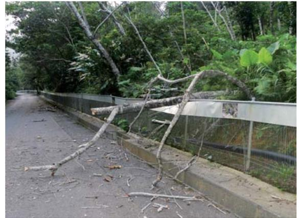
写真-4 倒木により損傷したマングース第一北上防止柵
