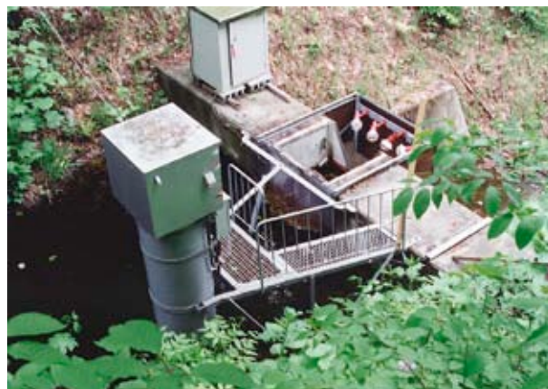
Photo. 2. 量水堰堤の全景（時雨 2 の沢） The gauging weir (Shigure-Ninosawa Basin)
