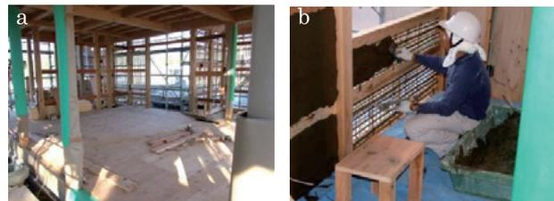
Photo 9. a: 竹小舞の施工、b: 土壁の施工
