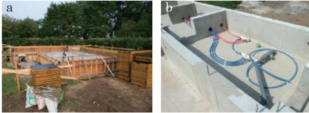
Photo 4. a: 基礎の施工、b: 床下の配管
