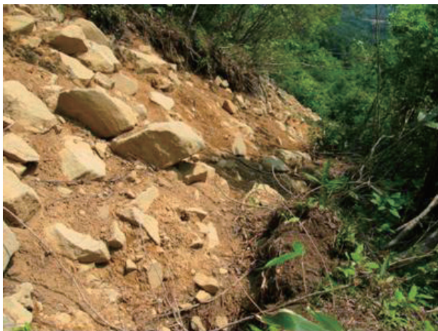
Photo 1 磐井川流域の新規崩壊の頭部付近で確認された亀裂。位置は Fig.2 を参照。亀裂は新規崩壊につながっている。
