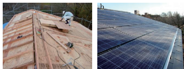
Photo 7. a: 屋根下地の施工、b: 太陽光発電パネルの設置
