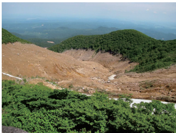
写真6 崩壊地对岸斜面の状況。2009年6月25日撮影。
