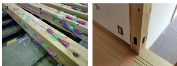
Photo 13. a: センサーの貼りつけ、b: センサー設置状況
