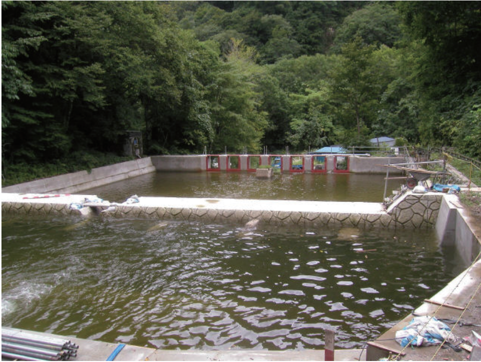
Appendix Photo 3-3 漏水防止工事完了後の上流側から見た初沢試験流域量水施設 (2006 年9月撮影)
