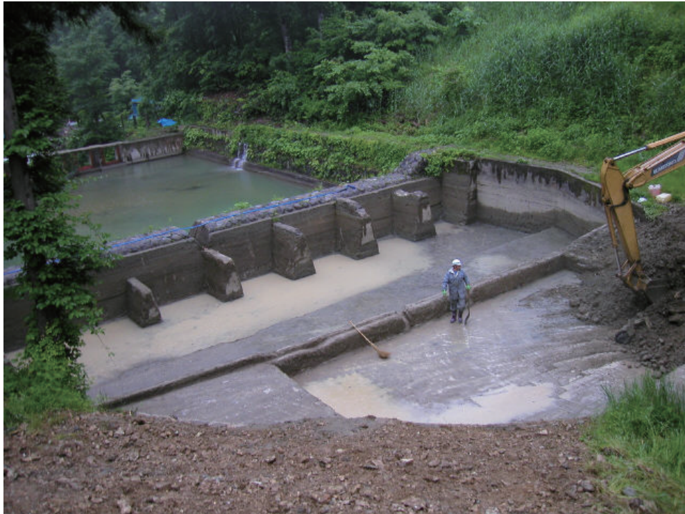
Appendix Photo 2-1 初沢試験流域量水堰堤と沈砂池の排土 (2002 年6月撮影)
