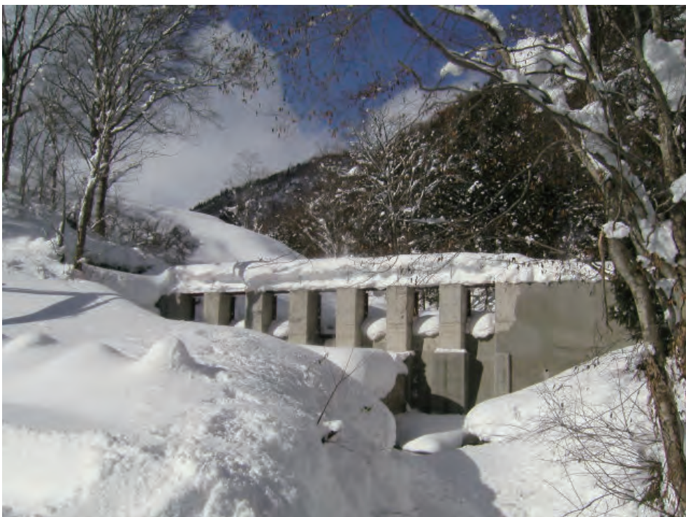
Appendix Photo 2 -6 改修工事完了後の初沢試験流域の量水堰堤 (バザン式Vノッチ) (2005 年12月撮影)
