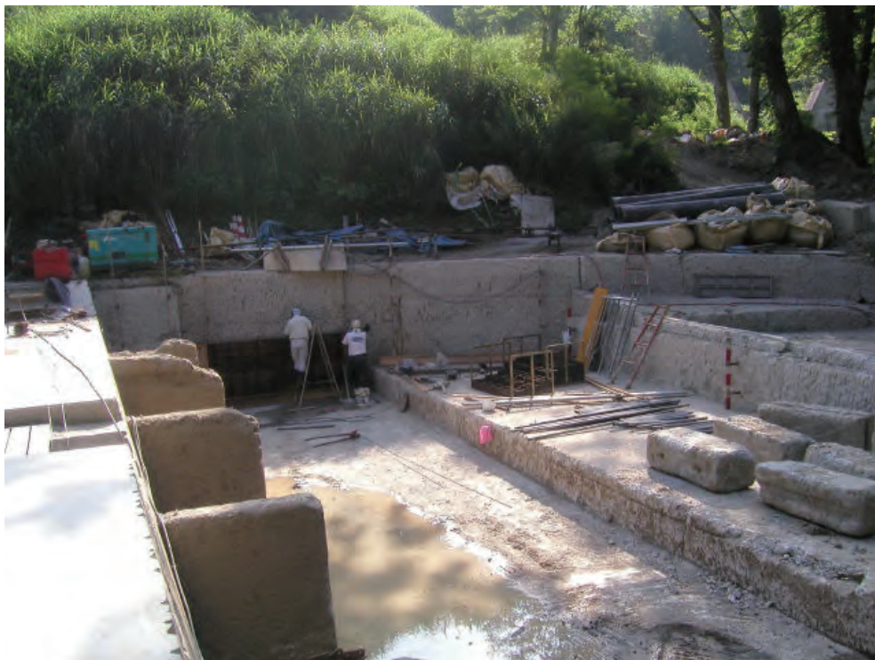
Appendix Photo 3 -1 初沢試験流域沈砂槽の漏水防止工事 (2006 年8月撮影)
