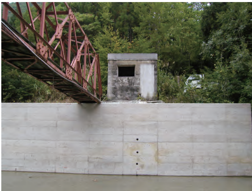
Appendix Photo 1-2 改修工事完了後の本流試験流域水路と水位計室 水路壁に測水井への導水孔が見える (2002 年9月撮影)
