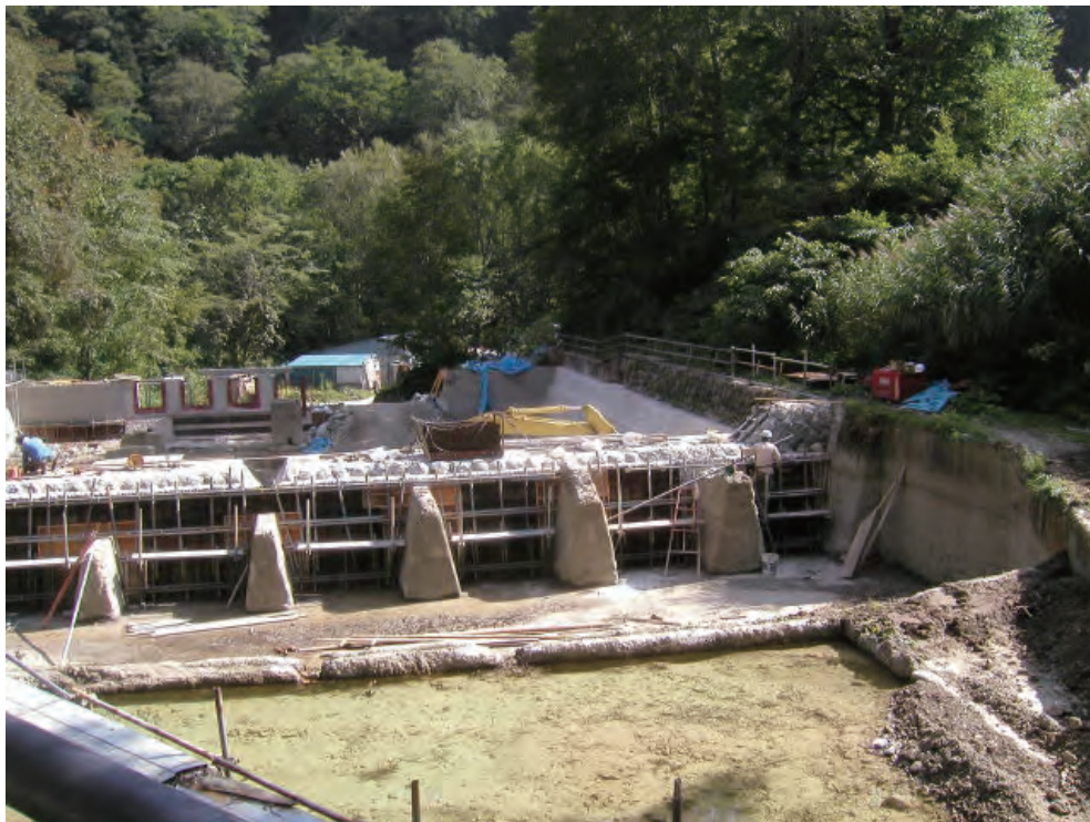
Appendix Photo 2 -3 改修工事中の初沢試験流域沈砂池 (手前) と土砂止堰堤を挟んで湛水池 (奥)と量水堰堤 (バザン式Vノッチ) (最奥) (2005 年9月撮影)
