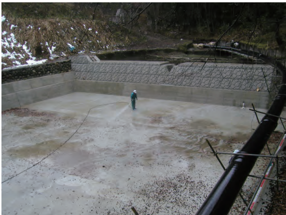
Appendix Photo 2 -4 改修工事完了後の初沢試験流域沈砂池 (2005 年11月撮影)
