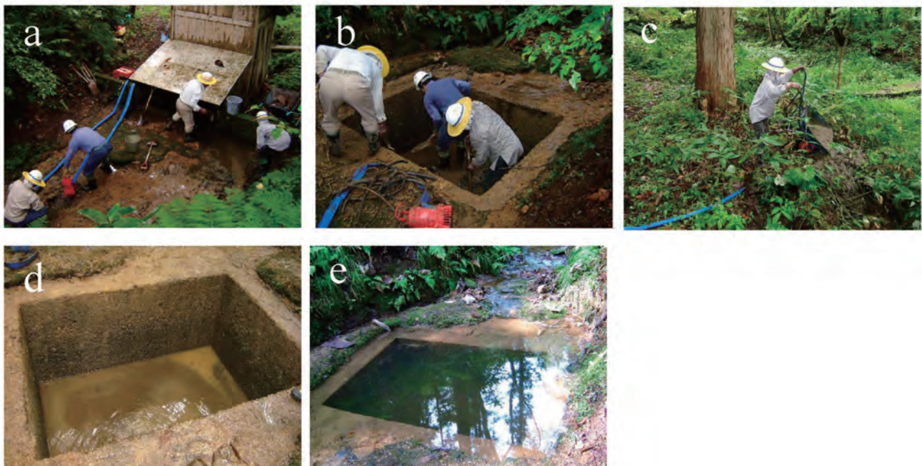
Photo 2. 1 号沢の沈砂槽における土砂浚渫
