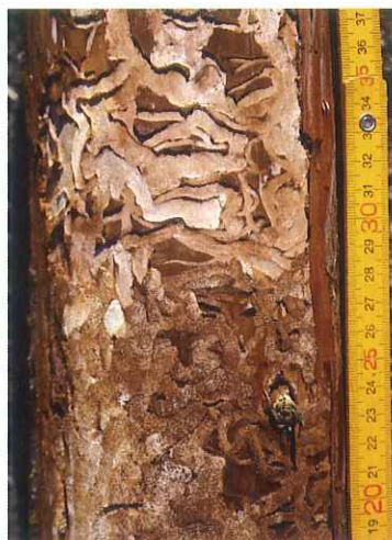
写真 15. ヒメスギカミキリ幼虫の食害痕（写真上半分は木屑を取り除いてあります。）
