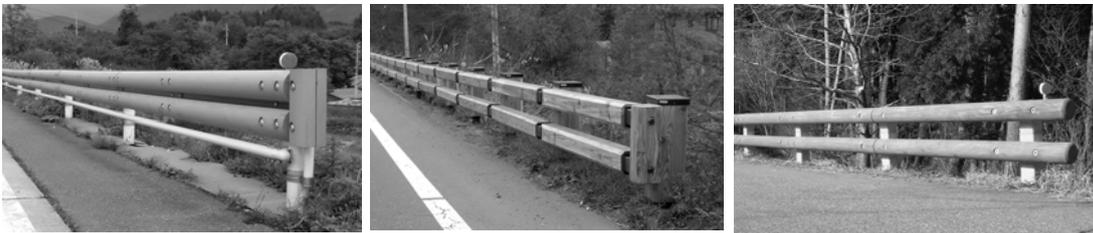
写真1 信州型木製ガードレール（左：1号型、中央：2号型、右：3号型）
