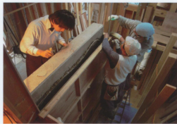
■ 架橋ボリ管を版築に埋め込む施工風景
