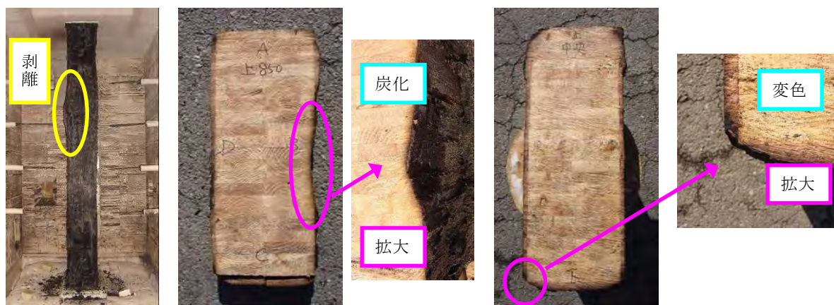
写真11 柱一部剥離 写真12 柱の荷重支持部「炭化」 写真13 梁の荷重支持部「変色」
