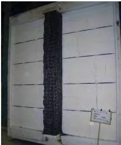
写真9 加熱後の状況 (柱・壁接合部試験体)
