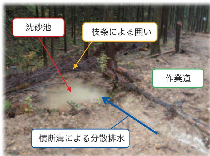
横断溝による分散排水と流末に設置された沈砂池
