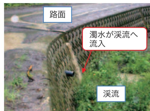
路面から溪流へ直接流れ込む濁水
