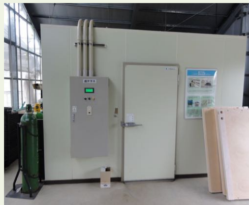
図1 植物工場の外観
