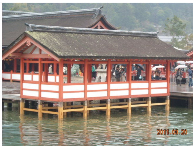
写真-2.4.3 厳島神社海上社殿廻廊根元材に使用された低分子フェノール樹脂処理木材
