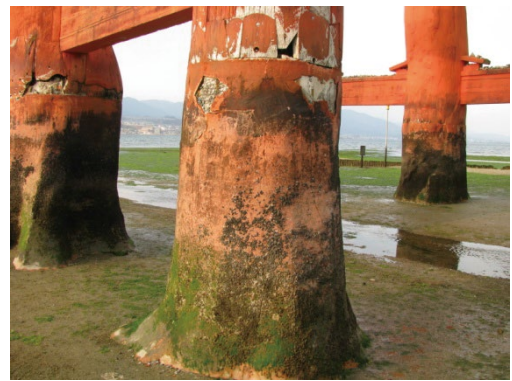
写真-2.4.5 ガラス繊維が被覆されている厳島神社大鳥居主柱下部（2010年1月撮影）
