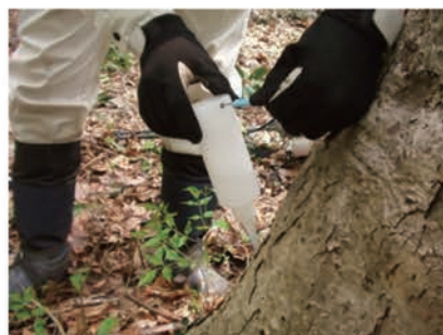
写真9. ボトルの端に目打ちで 穴をあけて自然圧で薬液注入
