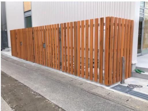
図4 CNF配合塗料を下塗りに用いて工場塗装した木材で作製したフェンス(高知県嶺北森林管理署)
