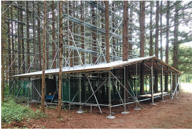
図2-1. 林内雨を遮断するためスギ林内に設置した10m四方の屋根と林冠にアクセスするための足場
