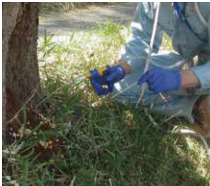
(写真32) 薬剤注入器での注入
