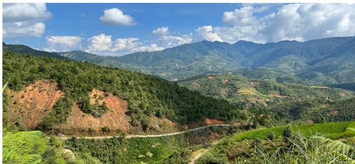
図 T06-1 道路開設による斜面崩壊
