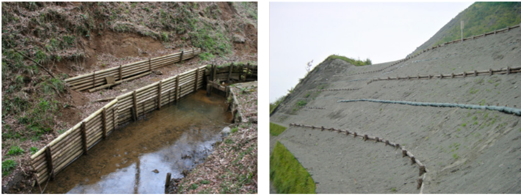
図 T07-1 適用が期待される山腹緑化工（左：柵工、右：筋工）
