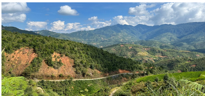
図 T06-1 道路開設による斜面崩壊
