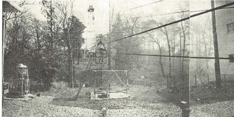
架空索集運材試験装置 水平距離 79m, 高さ 23m, 勾配 16°12'
