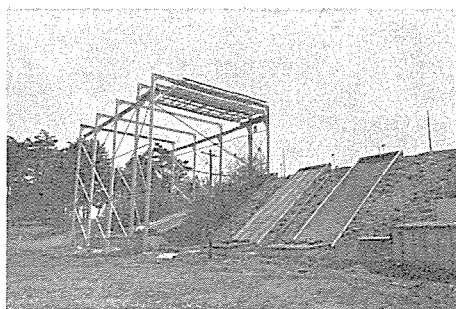
傾斜面浸透装置
