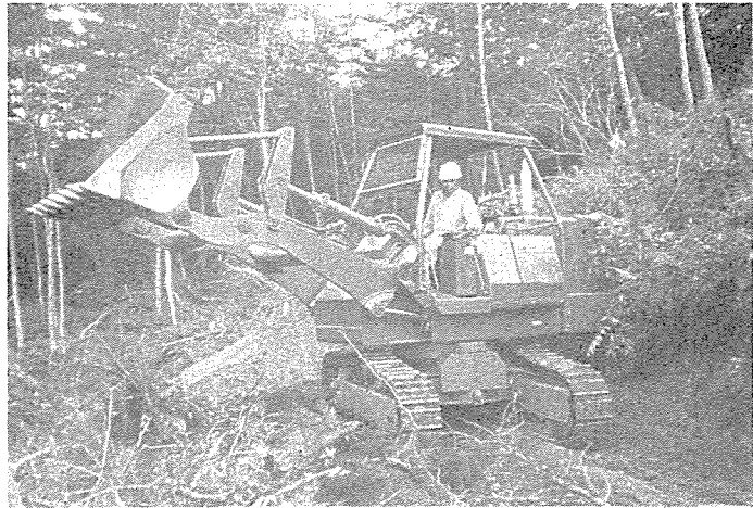
スウィングトラクタシヨベルによる林道施工試験
