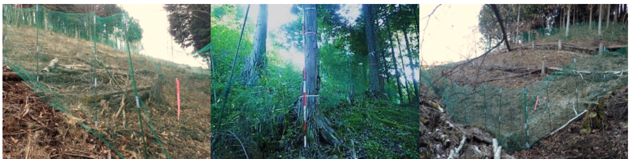
写真2 各区の設置状況（左から、A区、B区、C区）
