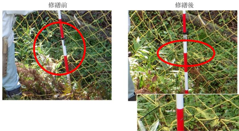
写真3 簡易補修の一例 (結束バンドを使ったネットの補修)
