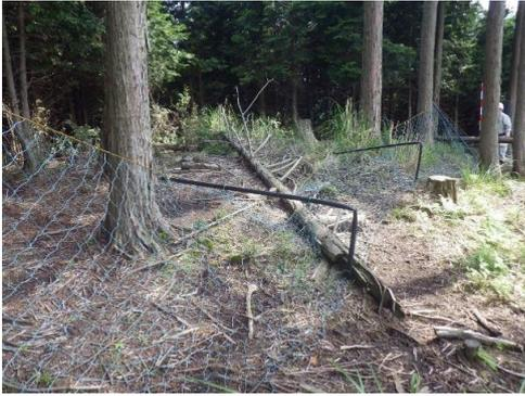
写真1 倒木により破損した侵入防止柵
