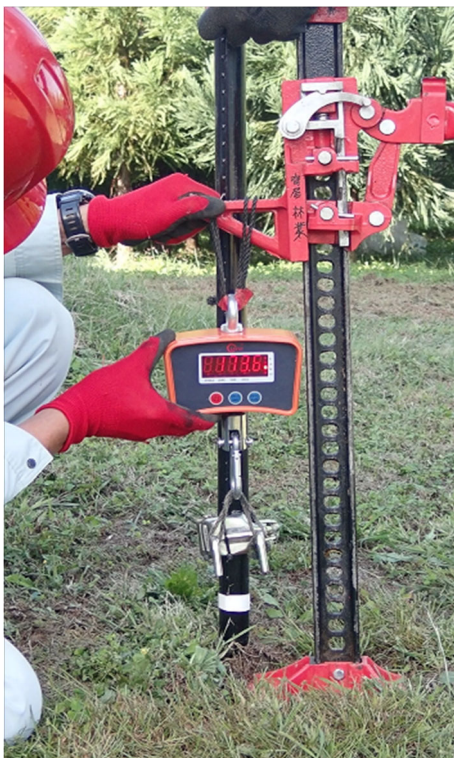
写真1 支柱引き抜き荷重試験
