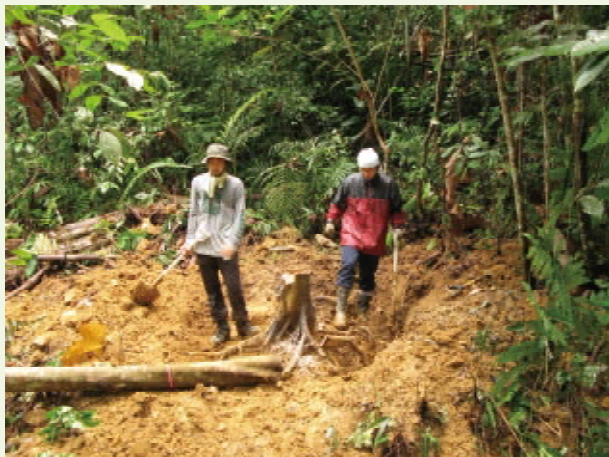
写真2 樹高17mのオオバギの根の掘り取り作業 この木の根は5人で丸2日ほどかかり掘り取った。
