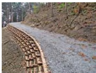
○丸太組工（積上工）により設置した作業道
