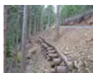
○丸太組工（のり留工）により設置した作業道
