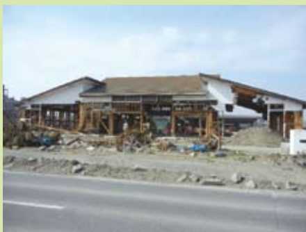
写真4 津波を受けて骨組みが残った大断面集成材構造 （宮城県石巻市）
