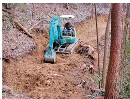
バックホウによる施工
