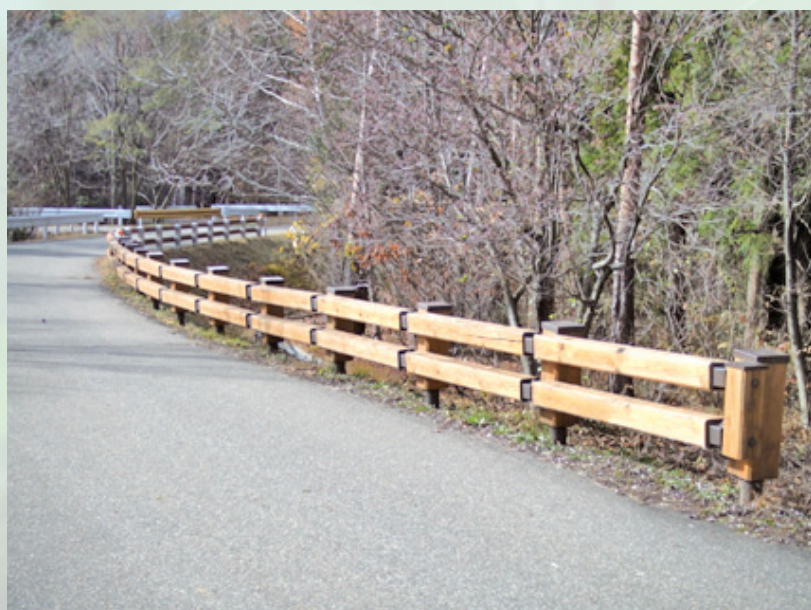
写真2 実用化された木製ガードレールその2
