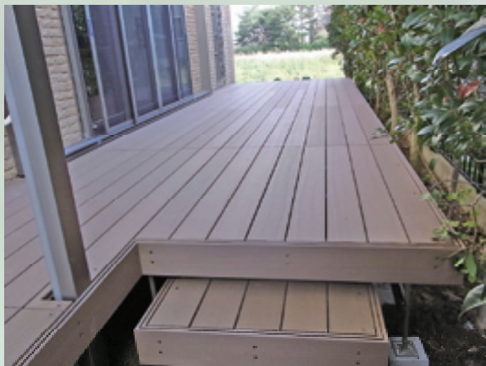
写真6 混練型WPC（木粉・プラスチック複合材）デッキ
