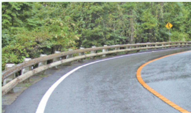
写真1 実用化された木製ガードレールその1
