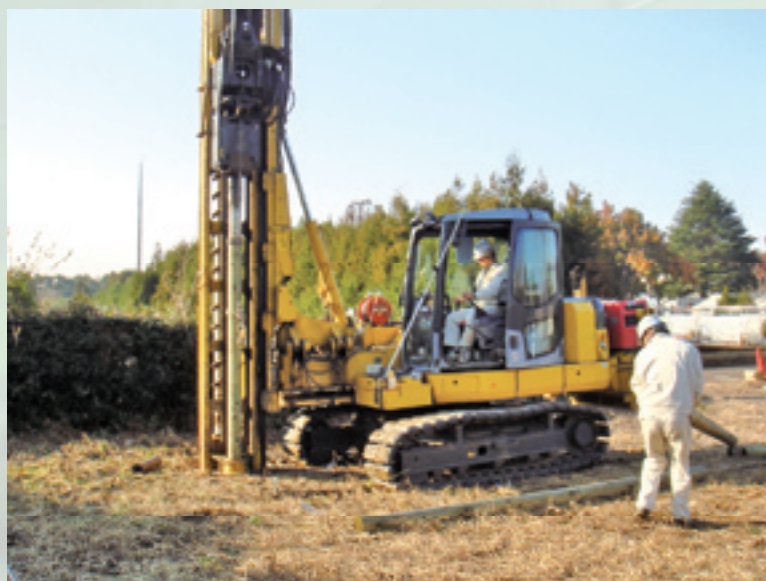
写真3 接合された間伐杭の打設試験
