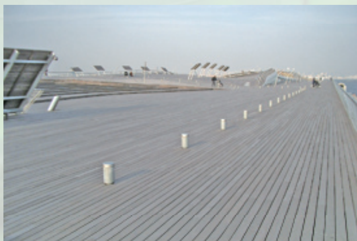
写真5 イペ材によるデッキ（横浜港大栈橋）
