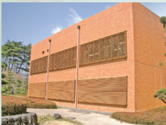
写真8 森林総研に取り付けられた木製ルーバー （2階部のルーバー角度は45度、間隔は1階部の2倍）
