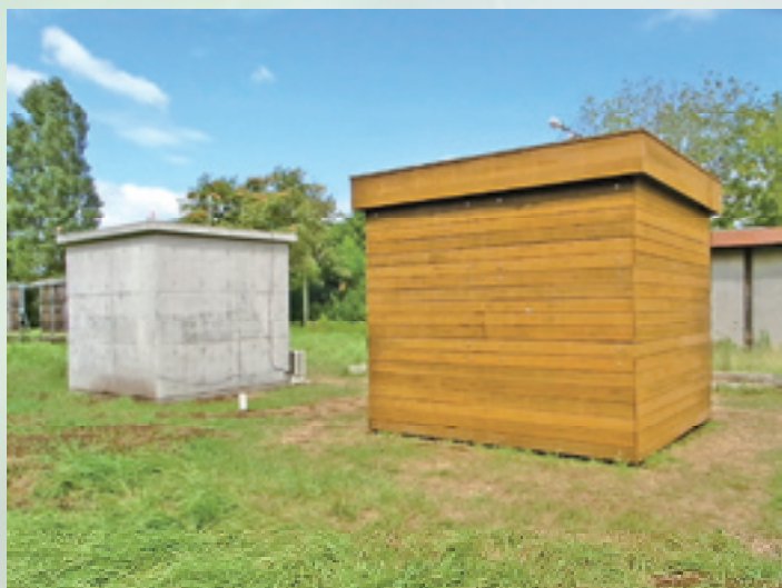
写真7 木製デッキ及びルーバーを被覆したRC造モデル棟（右）
