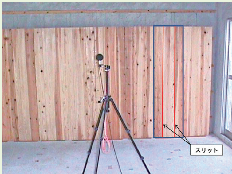
写真1 木質スリットパネルの設置風景
