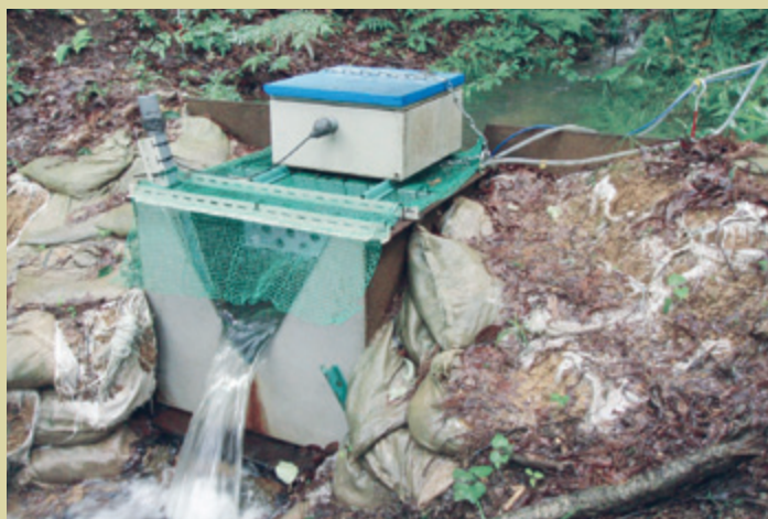
写真 流出水量を観測するための堰 総雨量90ミリの雨が止んだ直後に撮影。流出水量は多いが、渓流水はあまり濁っていない。
