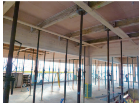
チューリッヒ工科大学構内に建設中の木造ビル (集成材の柱・梁にCLTの床)
